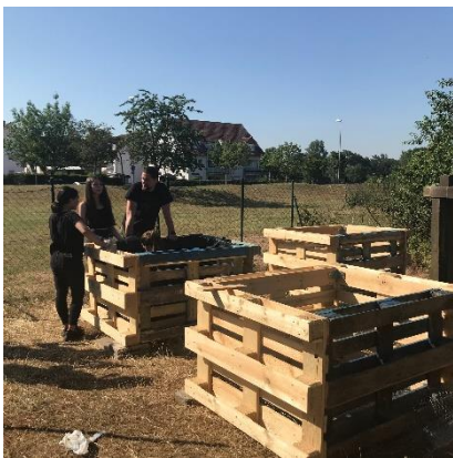
Bau der Hochbeete
